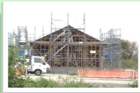
多目的グラウンド・テニスコート等施設管理棟
